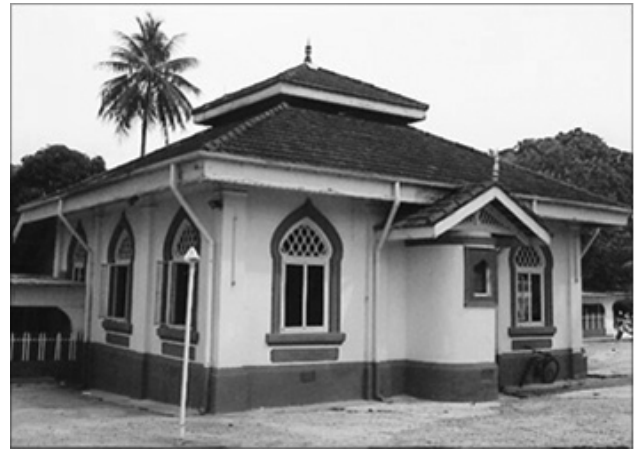
Bangunan Masjid Bidadari
